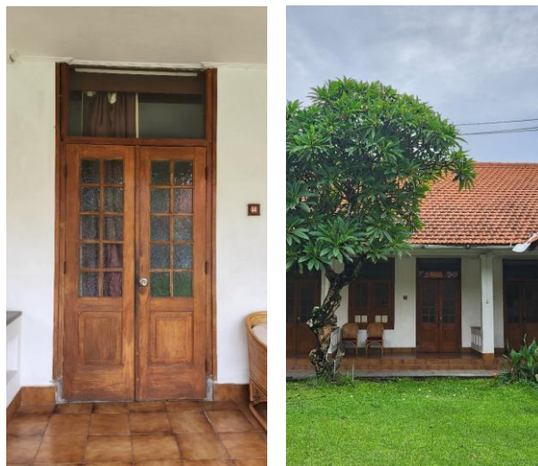
Gambar 7&8: Struktur Bangunan yang masih Asli
