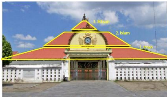
Gambar 3: Atap Masjid Gedhe Sumber: Dokumentasi Pribadi
